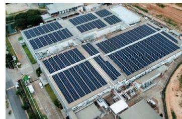
HOYA LAMPHUN LTD.に設置した太陽光パネル（年間発電量：約2,200MWh、年間CO<sub>2</sub>削減効果：約1,000t-CO<sub>2</sub>）
