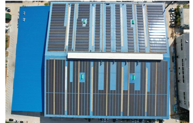
HOYA OPTICAL TECHNOLOGY (WEIHAI) CO.,LTD.に設置した太陽光パネル（年間発電量：約1,300MWh、年間CO2削減効果：約800t-CO2）
