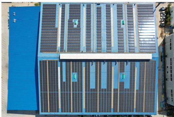
HOYA OPTICAL TECHNOLOGY (WEIHAI) CO.,LTD.に設置した太陽光パネル（年間発電量：約1,300MWh、年間CO2削減効果：約800t-CO2）
