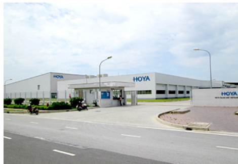
2011年稼働開始した最新鋭のベトナム工場
