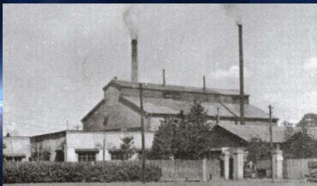
創業当時の保谷工場（ガラス工場を特徴づける排熱屋根と煙突が見える）
