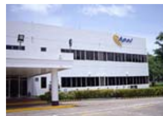
フィリピン・セブ島の工場外観
