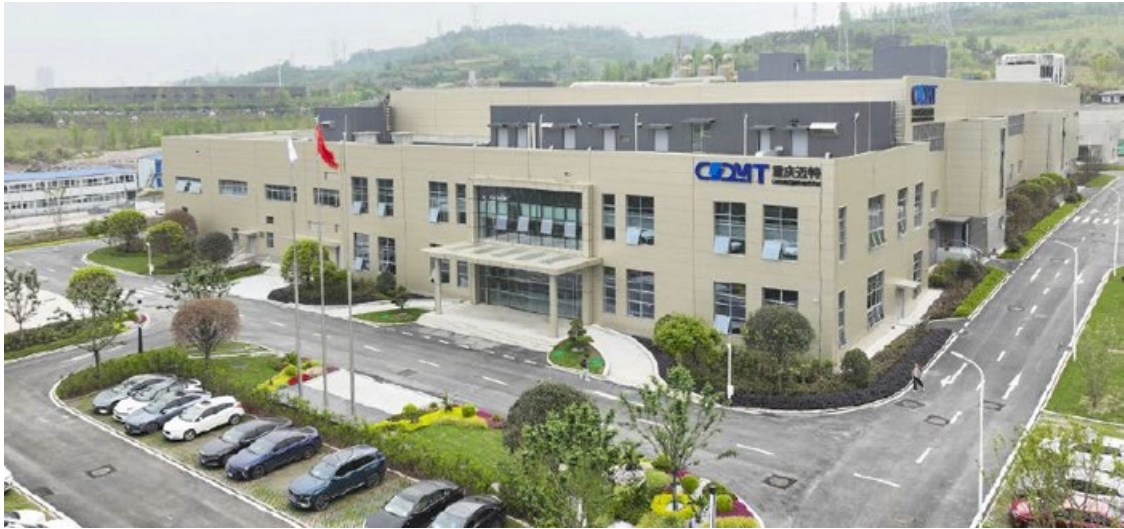
Chongqing MasTek Electronics Co., Ltd. (中国・重慶市)
