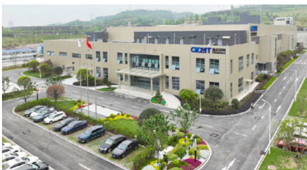
Chongqing MasTek Electronics Co., Ltd.（中国・重慶市）
