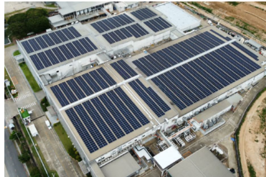
HOYA LAMPHUN LTD.に設置した太陽光パネル（年間発電量：約2,200MWh、年間CO 2 削減効果：約1,000t-CO 2 ）
